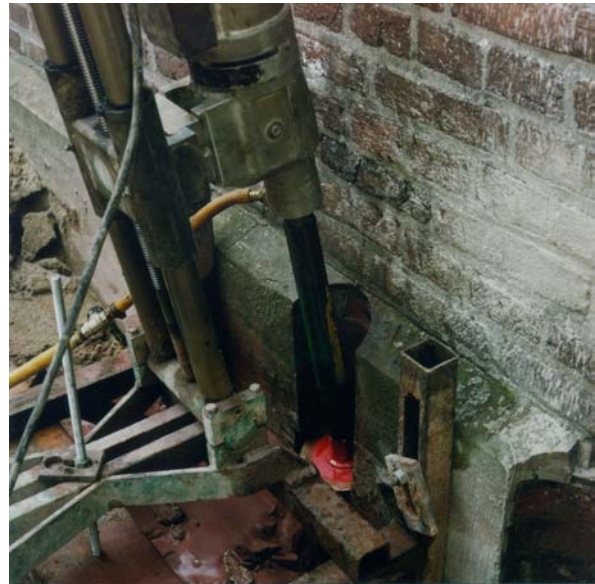
het boren van de gaten door de fundering
