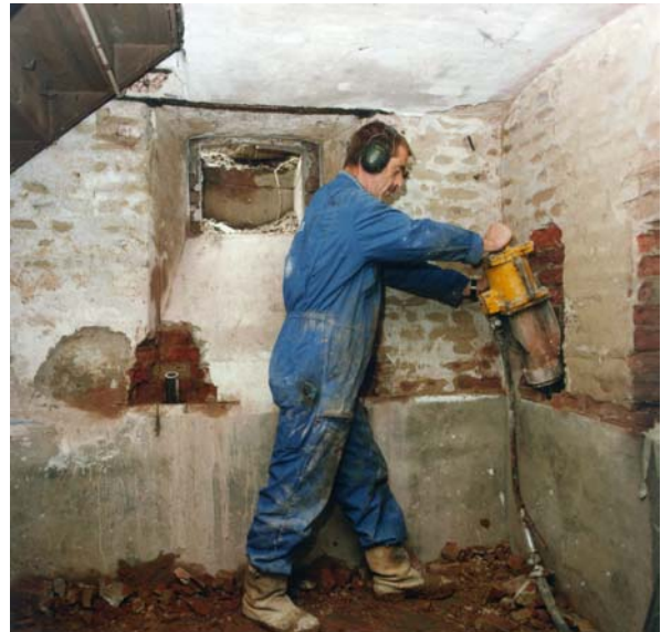
het maken van de palen in de kelder met handgereedschap
