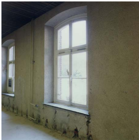
na gereedheid van de constructieve werkzaamheden
