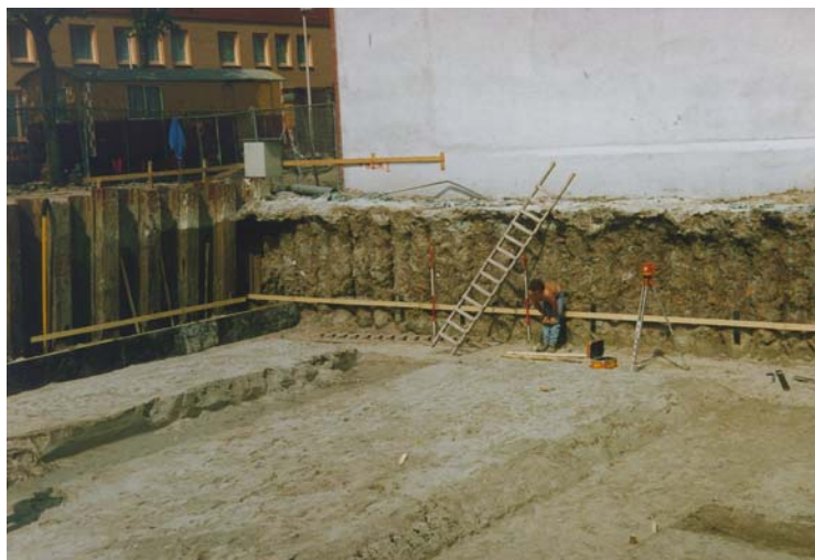
SCHROEFINJECTIE-PALENWAND (trillingvrij, grondverdringend)
